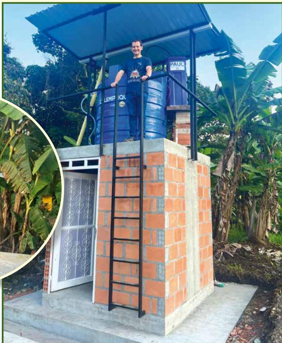
Turm mit Wasserfilter und Vorlagebehälter
